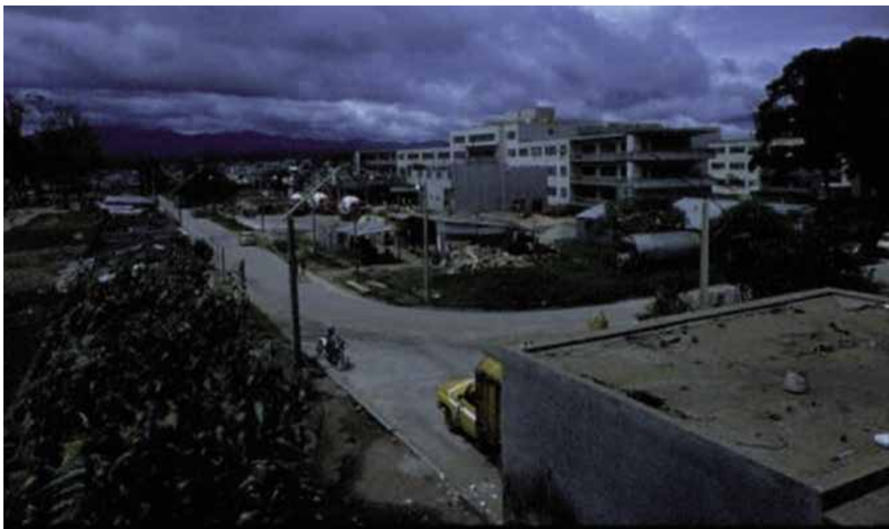
El edificio grande de 4 niveles corresponde a la parte posterior del Hospital Roosevelt. En la parte anterior se ve el área de construcción de la Unidad.
