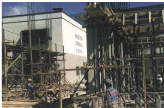
Nueva construcción, frente al antiguo edificio de la Unidad Nacional de Cirugía Cardiovascular
