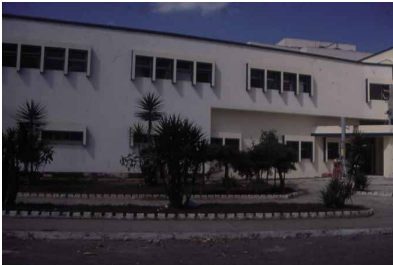
Fachada del edificio terminada y pintada
