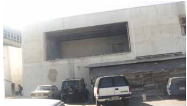
Módulo construido en el área cedida por el Hospital Roosevelt en donde se ubicará el equipo de rayos X donado por Boston, el cual estuvo guardado en una caseta provisional de lámina por dos años, para protegerlo del medio ambiente.
