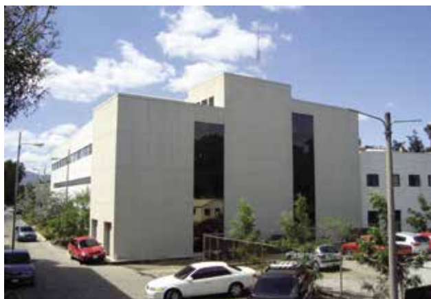
Exterior de la rampa externa
