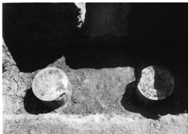
Grandes pilotes de concreto como parte de los cimientos seleccionados por la naturaleza del terreno.
