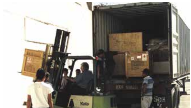
Como las puertas del edificio no eran lo suficientemente amplias para admitir las voluminosas cajas conteniendo el equipo y accesorios, fue necesario usar montacargas para introducir el equipo por el lado exterior.
