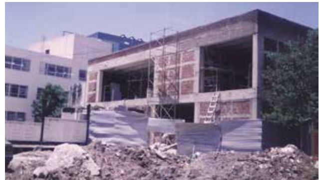
Módulo en construcción para ubicar el equipo de rayos X de Boston. Atrás el Hospital Roosevelt.
