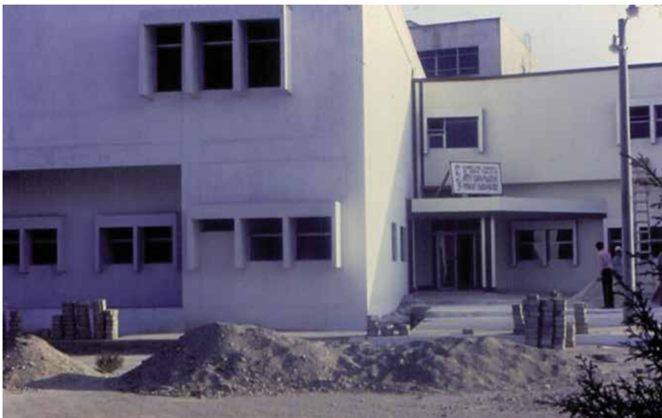
Vista frontal de la Unidad de Cirugía Cardiovascular en construcción
