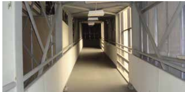
Interior de la rampa externa
